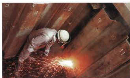
Cutting of sheet pile シートパイル溶断
