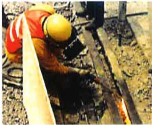
Exchange of highway 高速道路のリフレッシュ作業
