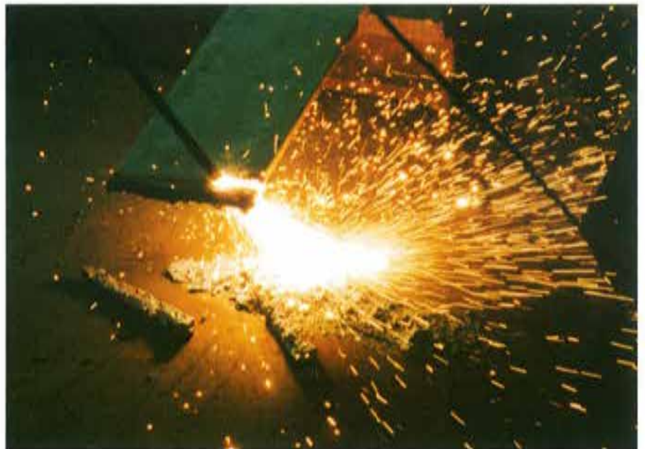
Cutting of stainless plate ステンレス板の溶断
