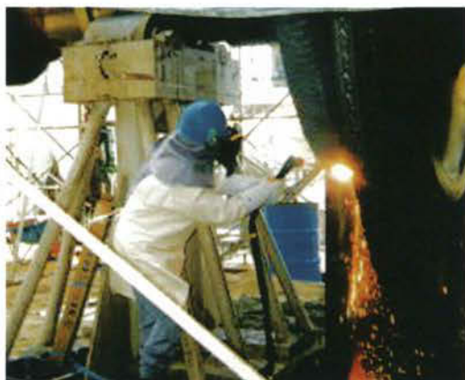
Demolition of generator turbine shaft 発電用タービンシャフトの解体
