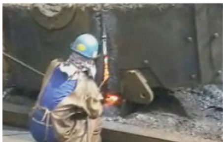
3. 大型プラント熔断解体作業
