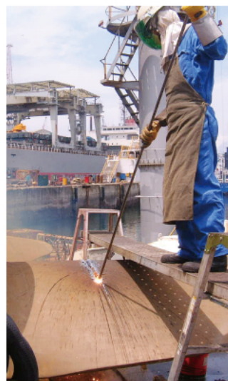
大型スクリー解体作業
