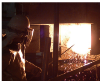
炉前出湯口の開削作業
