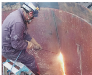
ケーシング熔断作業
