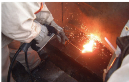
1. 高速道路のリフレッシュ作業
