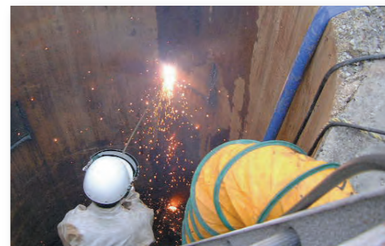
閉所作業(ケーシング鏡切り)
