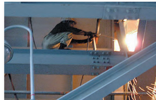
高所作業(プラント解体)
