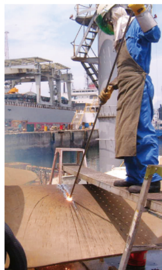
大型スクリー解体作業
