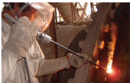
3. 大型製造プラントの解体
