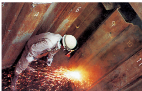
1. シートパイル熔断
